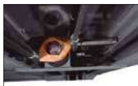
Testigo de seguridad que advierte sobre fallos de nivelación de las pasarelas.
